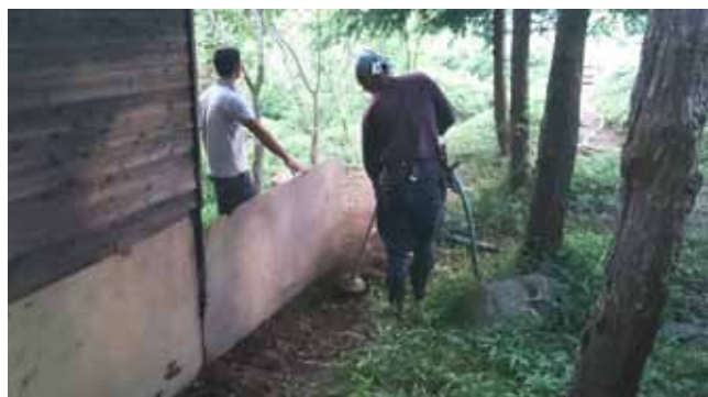
エアークラッパ機で溝を掘る
