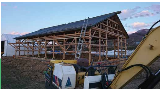
建設中の倉庫
